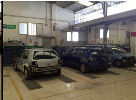
ZONA DSE ASPIRACION
